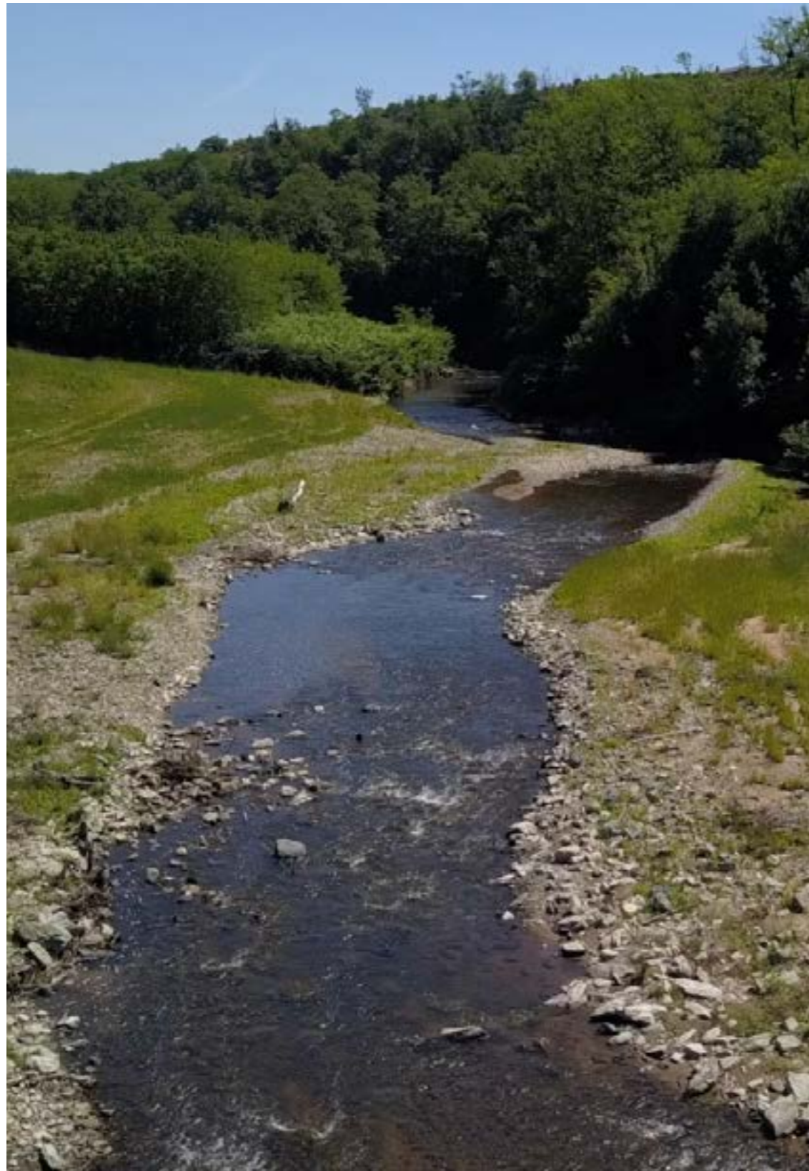
Vue aérienne du seuil des Grenadières après les travaux
