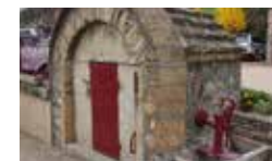
Eaux souterraines dans le puit fermé de Sourcieux-Les-Mines.
